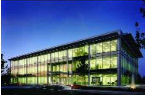
Verwaltung Rack-Room, Charlotte, N.-Carolina, USA Bürogebäude mit Cafeteria und Rechenzentrum
