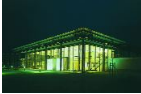
Stadthalle Rheinau Stadthalle mit Vereinsbereichen und Gastronomie
